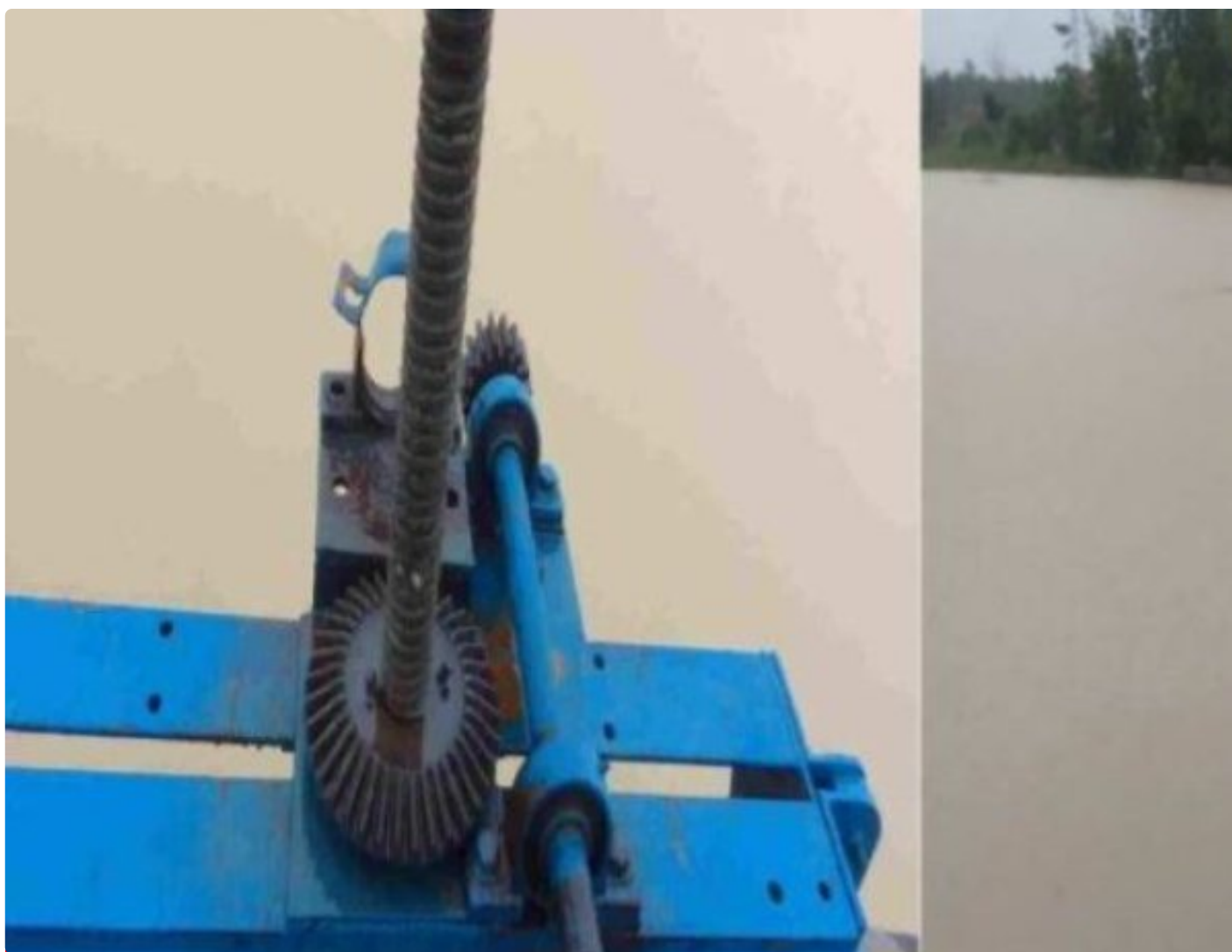
Pintu air Albaret Simpang Mesuji
